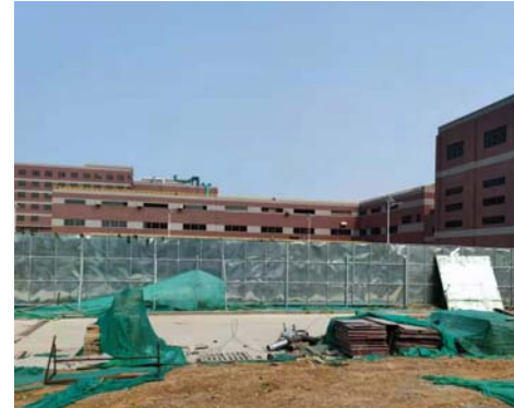
拟新增变电站东侧
