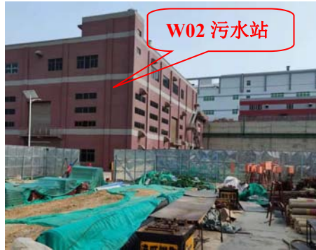
拟建变电站东南侧
