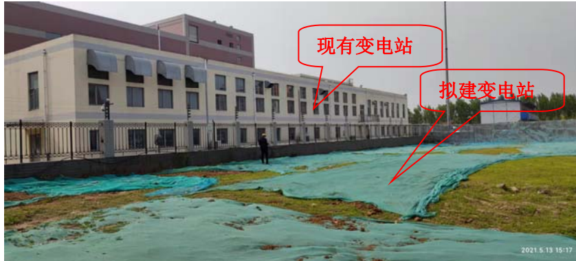
拟建变电站站址及东侧现有变电站
