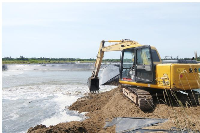
图 2.2-16 养殖池围堰拆除施工示意图
